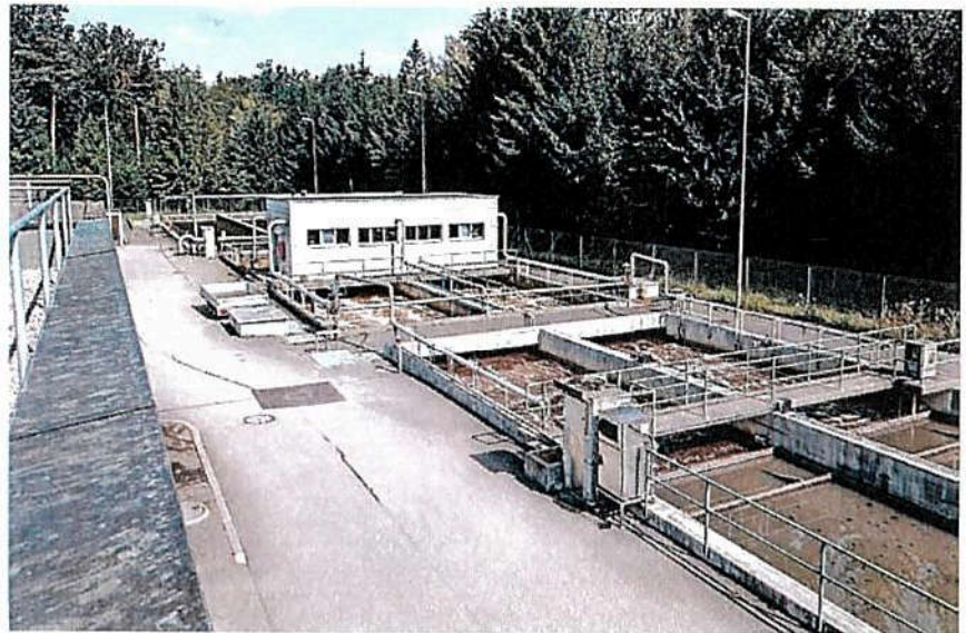
Die Kläranlage in Muntelier soll nach ihrer Erneuerung zusätzlich die Abwässer aus der Region Kerzers reinigen.
